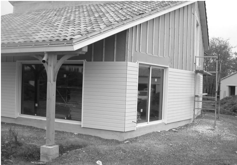
Photographie 3 : la majorité des poteaux travaillent en compression axiale avec un risque de flambement
