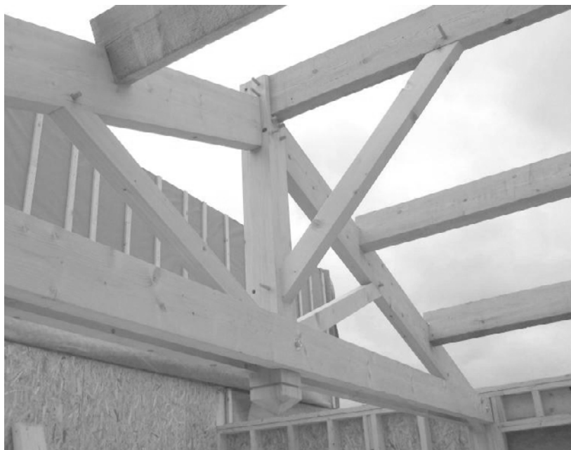
Photographie 1 : cette ferme est réalisée avec des assemblages à entailles, excepté l'entrait assemblé avec les arbalétriers par juxtaposition avec des boulons.
