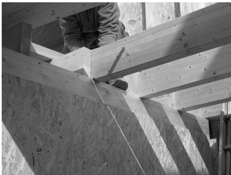
Photographie 4 : la compression transversale est systématique au niveau des appuis d'une poutre
